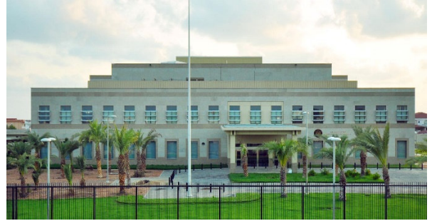
Şekil 9: ABD Cibuti Büyükelçilik Binası (İnternet Kaynağı-5)
