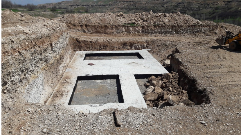
Şekil 3. 2 Bodrum temel hatılı
