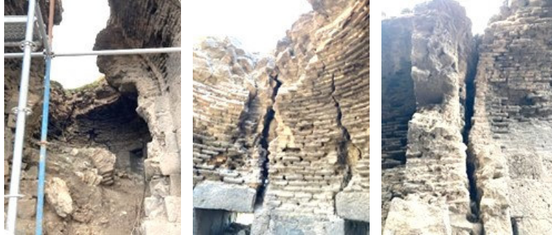
58 numaralı burcun tuğla kubbesinde meydana gelen çatlaklar ve burç duvarı ile burç arasında meydana gelen ayrılma (2023)
