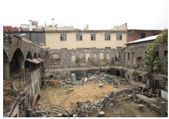
Doğu Avlu Cephesi
