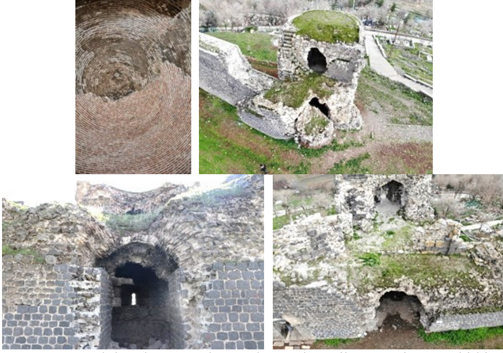
Şekil 10. 62-65 numaralı burçlar arasında meydana gelen mikroorganizma ve bitki oluşumları
