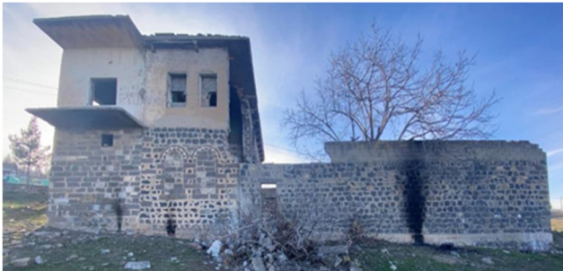
Şekil 13. Yapı doğu cephesi
