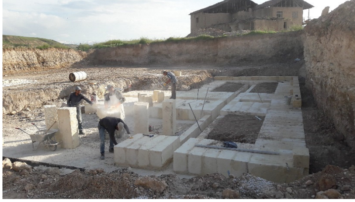
Şekil 3. 5 Temelin birinci sıra taşları döşeme
