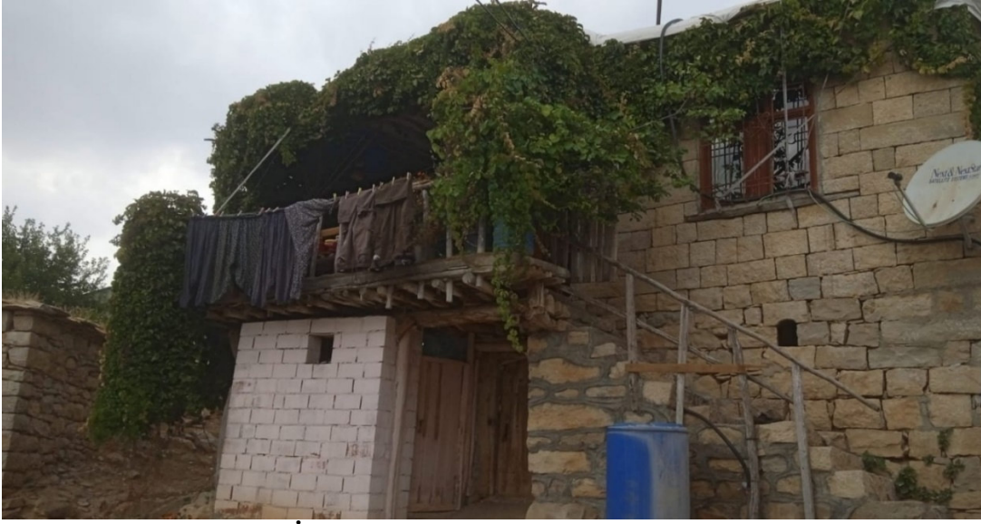
ŞEKİL 24 – 6 Numaralı evin güney cephesi
