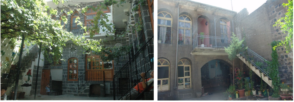
Şekil 2.1 Sıcak kuru iklim bölgesinde çevresel faktörlere bağlı olarak inşa edilen geleneksel Diyarbakır evleri
