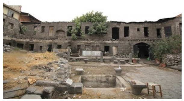
Güney Avlu Cephesi
