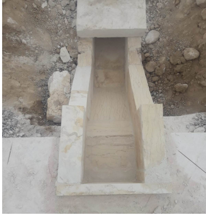
Şekil 3. 30 Galeriyi kanalı havalandırma çıkışı
