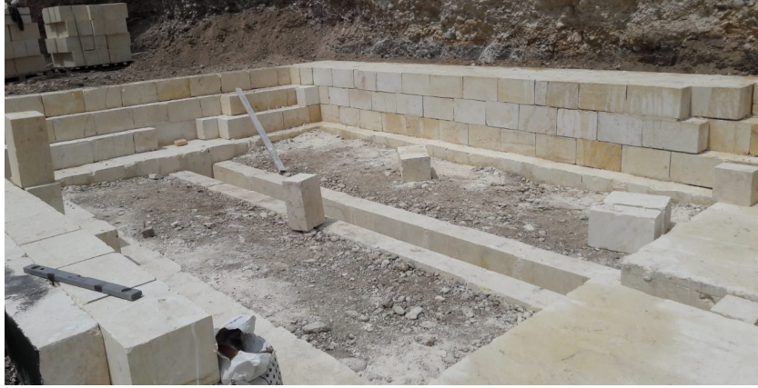
Şekil 3. 9 Kesme yontu taşların bağlantılı olarak örülmesi
