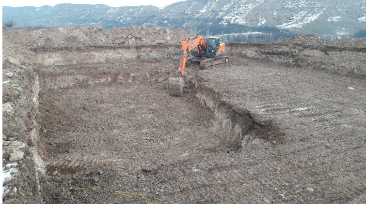
Şekil 3. 1 Binanın temelini açılması
