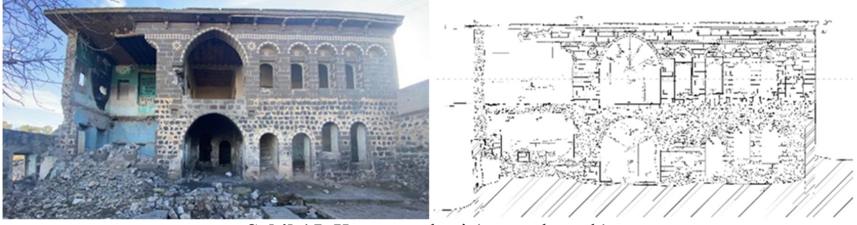
Şekil 15. Kuzey cephesi (güney kanadı)
