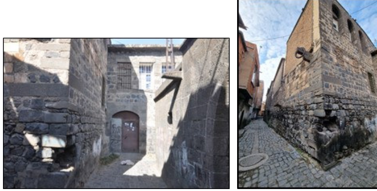
Şekil 18,19 II. Yapıya ait sokak ve avlu cepheleri
