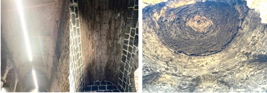
Tuğlanın Tonoz ve Kubbelerde Kullanımı
