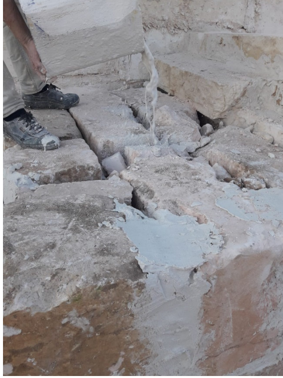
Şekil 3. 7 Temel taşlarının arasına sulu harç dökülmesi
