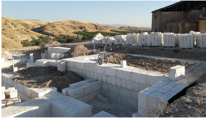
Şekil 3. 6 Temel taşları döşeme
