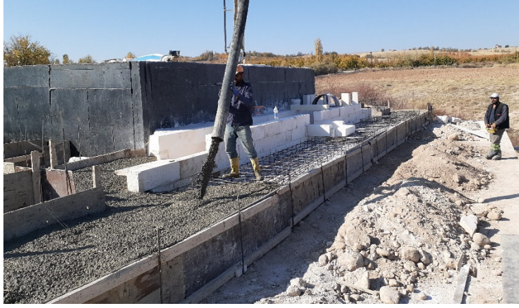
Şekil 3. 23 Havuz etrafı betonarme temel hatılları dökülürken
