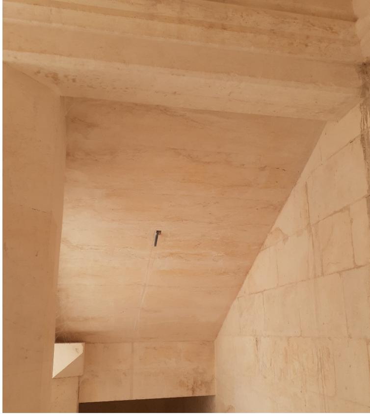
Şekil 3. 21 Merdiven altı eğik döşeme alttan
