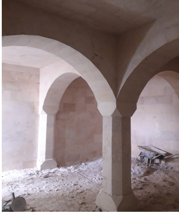
Şekil 3. 14 Riyad altı orta kolon ve kemerler
