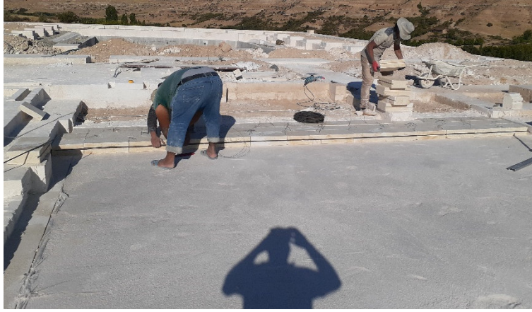
Şekil 3. 12 Riyad bodrum döşemesi kesme yontu taşından yapılırken
