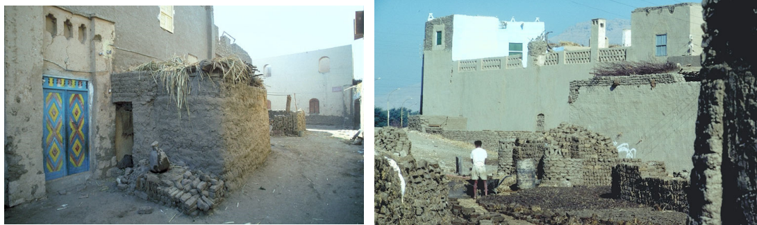
Şekil 3.2 Yeni Gurna Köyü'nde yerel malzeme kullanımı (Url:2)
