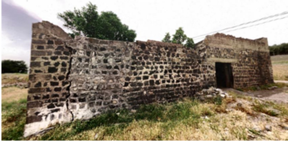
Şekil 11. Yapı kuzey cephesi
