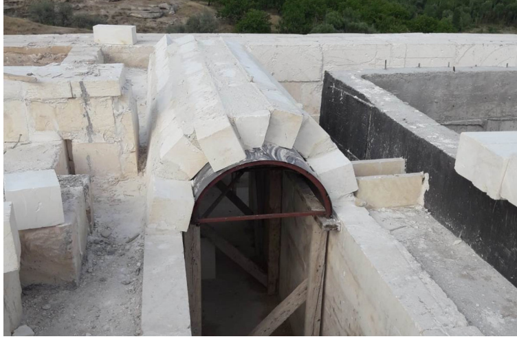
Şekil 3. 29 Havuz etrafı galeri kanalı basık tonoz
