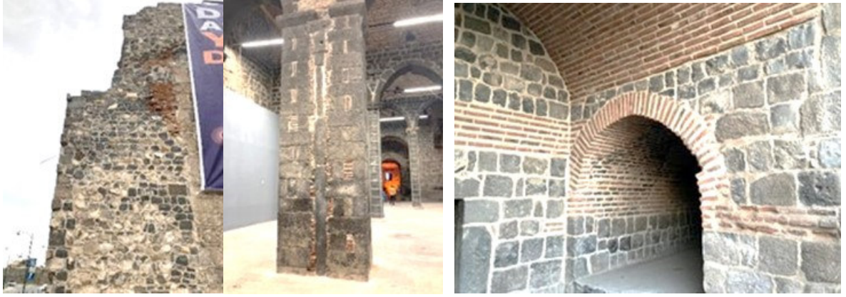
Tuğlanın Duvar, Taşıyıcı Ayak ve Hatılda Kullanımı
