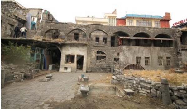
Kuzey Avlu Cephesi
