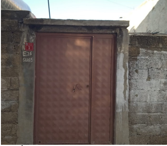
ŞEKİL 16- 3 Numaralı ev avlu kapısı
