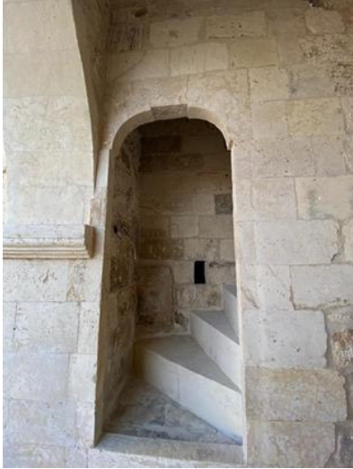
Şekil 10. 1.kata çıkan merdiven
