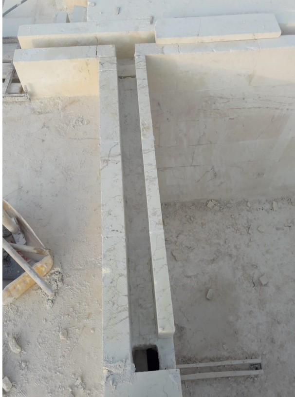
Şekil 3.32 Elektrik ana hattı için taşa kanal açılması
