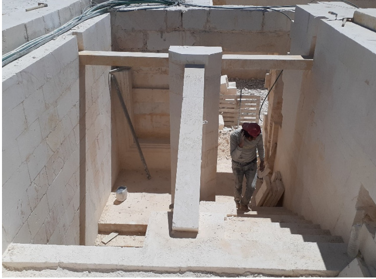
Şekil 3. 20 Merdiven kollarını taşıyan taş kirişler
