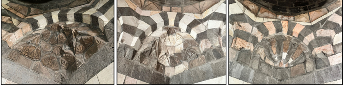
Şekil 17 Tromp Detayları
