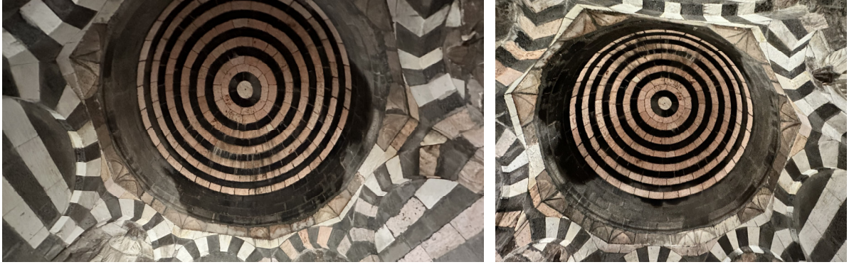
Şekil 21 Kubbede yağmur suyunun etkisi
